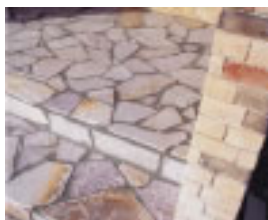
天然石による割石 貼り(玄関ポーチ)
